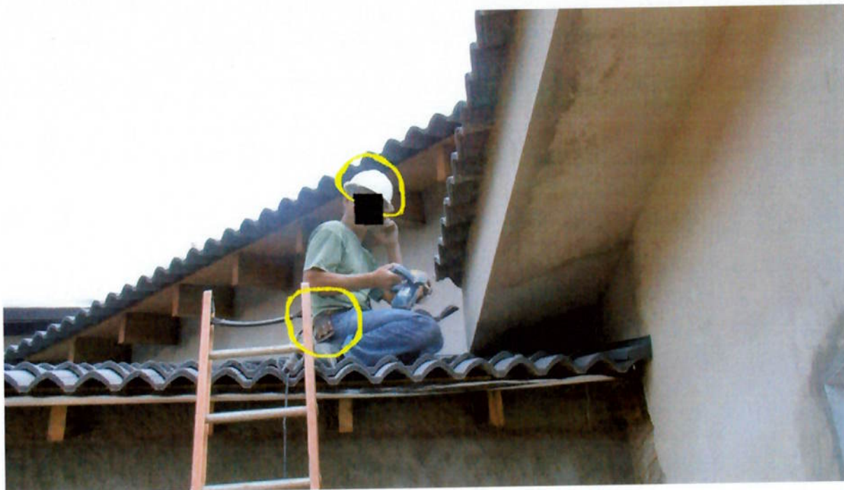
Figura 11: Pedreiro trabalhando sem proteção adequada. Fonte: foto da autora
