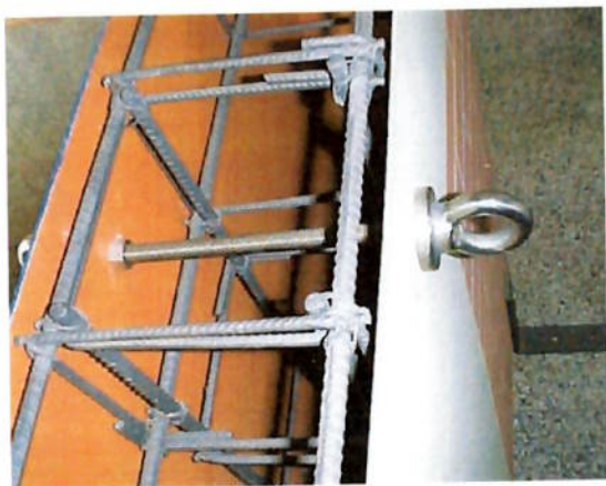
Figura 35: Ponto de ancoragem dentro da viga de concreto. (Sintraconsp, 2010)
