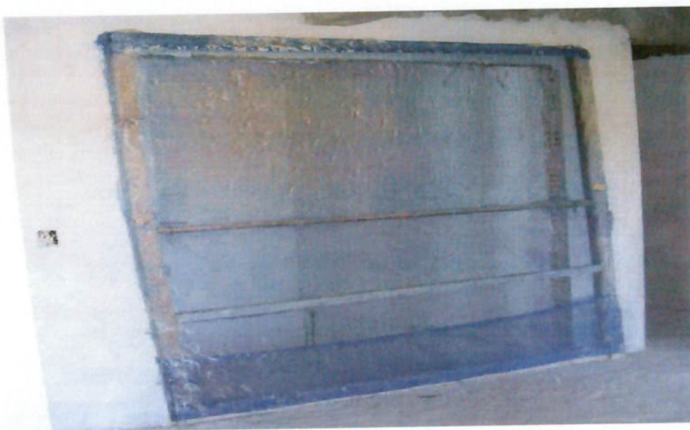
Figura 41: Sistema de proteção com fechamento total da abertura (FUNDACENTRO,2001).
