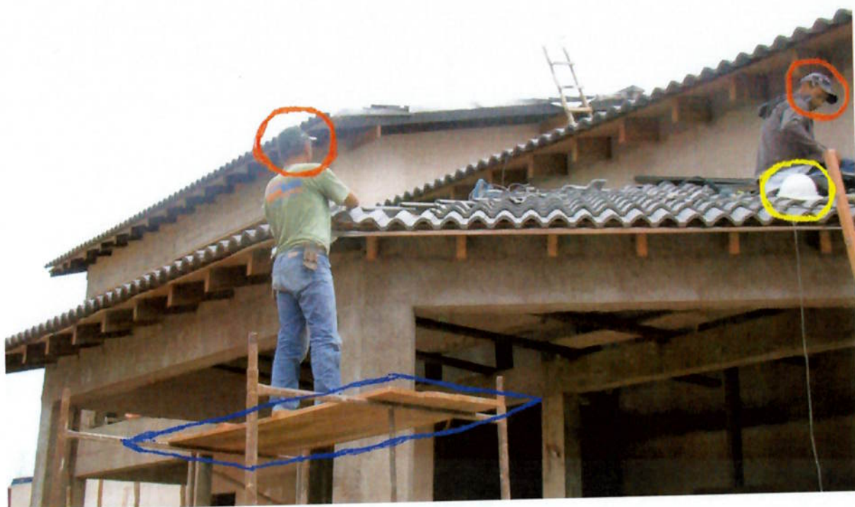
Figura 10: Pedreiro e calheiro, ambos sem EPI's trabalhando em altura. Fonte: foto da autora
