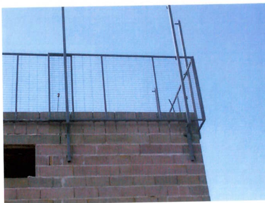
Figura 32: Guarda-corpo na periferia com tela. Fonte: Segurança e trabalho (2010)
