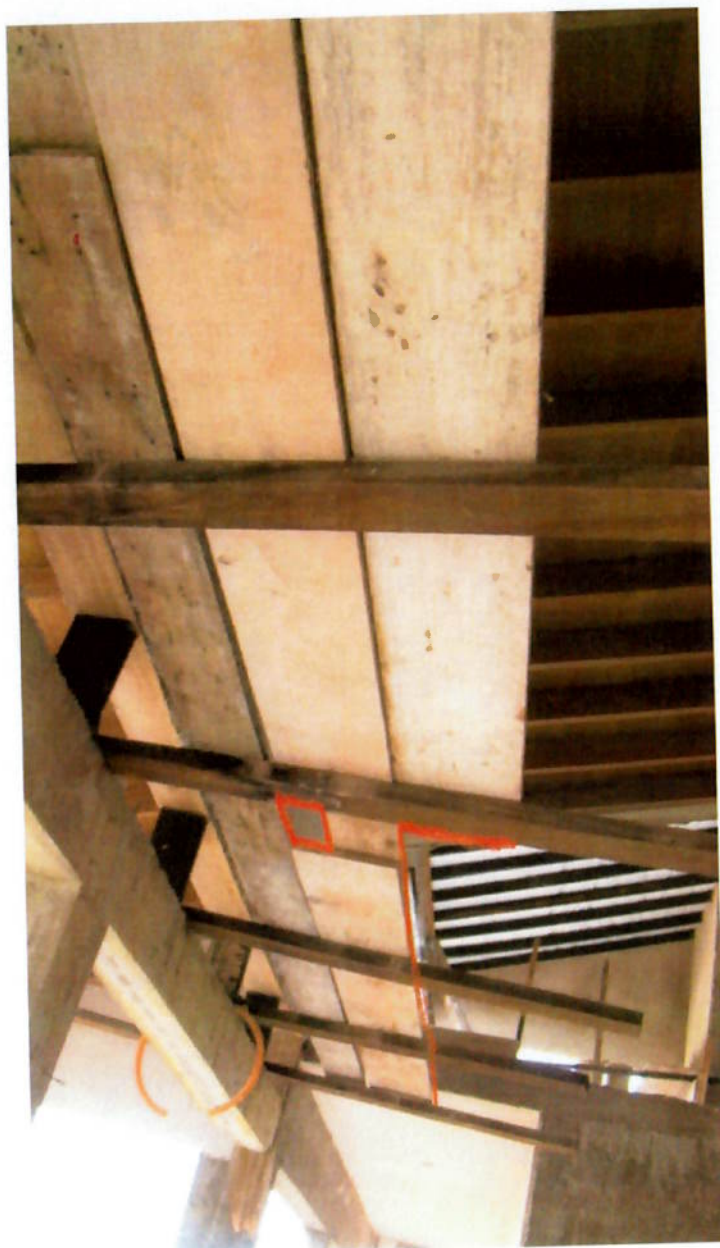
Figura 09: Tábuas desalinhadas deixam buracos no andaime (marcado em vermelho na Figura). Fonte: foto da autora
