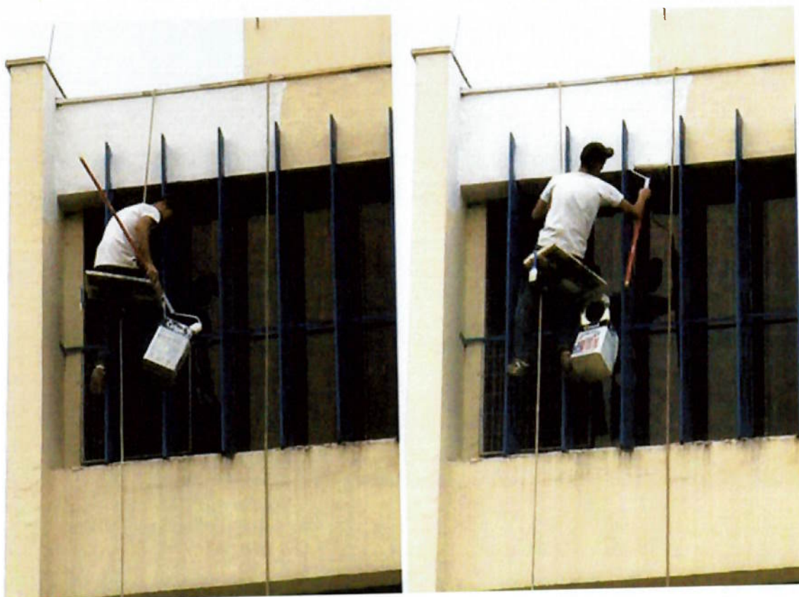
Figura 14: Cadeira Suspensa improvisada. (Globo, 2010)
