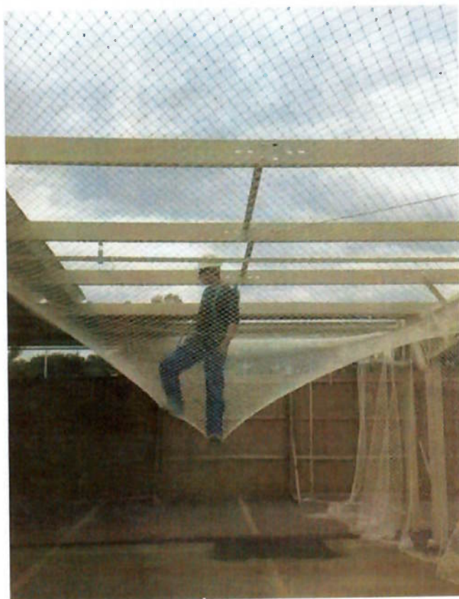
Figura 37: Rede de proteção. (Proteção, 2009)
