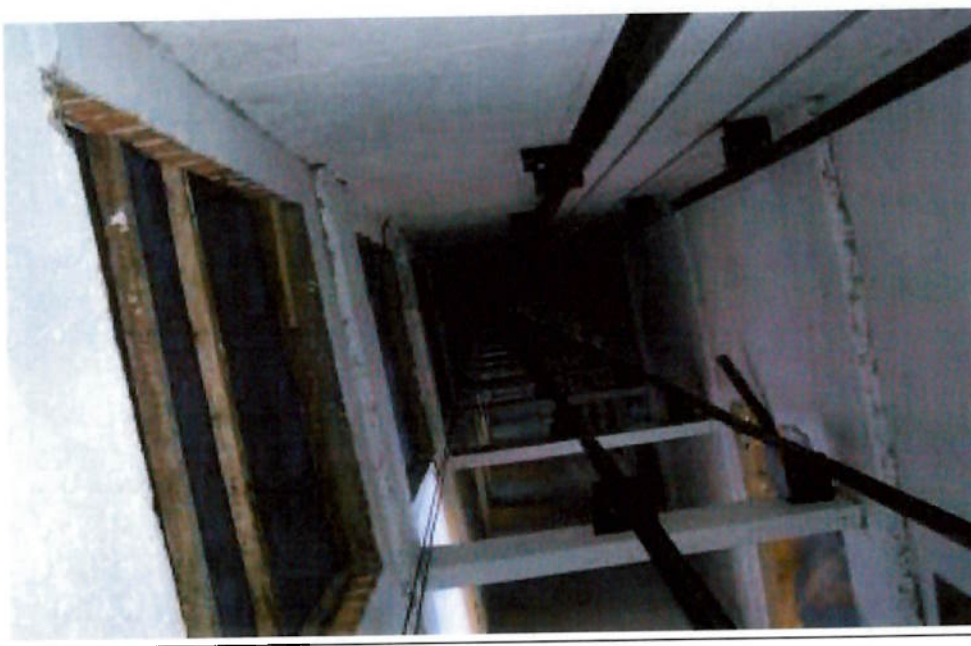
Figura 41: Sistema de proteção com fechamento total da abertura (FUNDACENTRO,2001).
