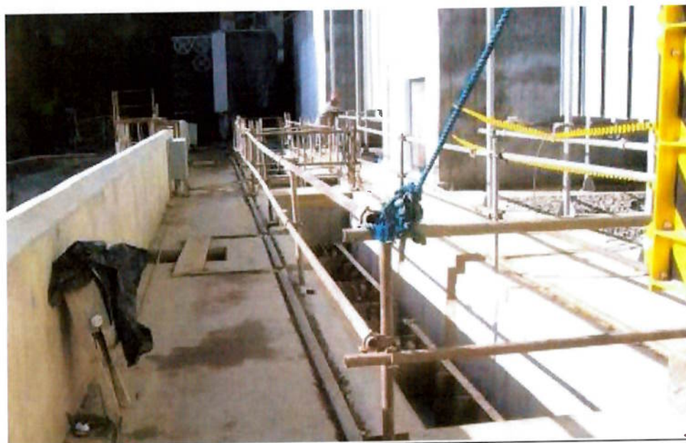
Figura 31: Guarda-corpo provisório em tubos de aço. Fonte: Segurancaetrabalho (2010)
