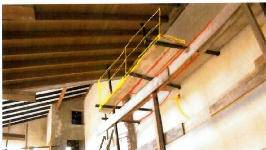
Figura 08: Andaime de madeira montado de forma incorreta. Fonte: foto da autora
