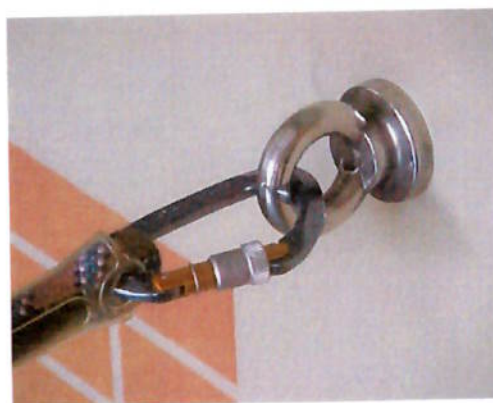
Figura 36: Ponto de ancoragem com cabo guia fixado. (Sintraconsp, 2010)
