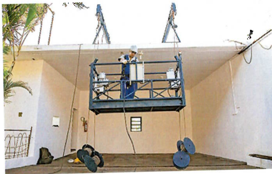
Figura 12: Andaime Suspenso Mecânico Pesado. (Construcaomercado,2010)
